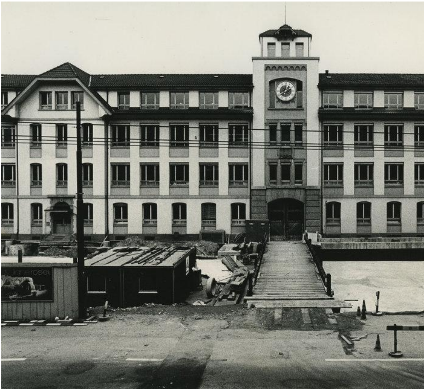
1/7 1895: Das Fabrikgebäude der Hasler im Berner Mattenhofquartier zeugt vom grossen Selbstbewusstsein und der Aufbruchstimmung in der Fernmeldebranche. Urs Lauterburg
